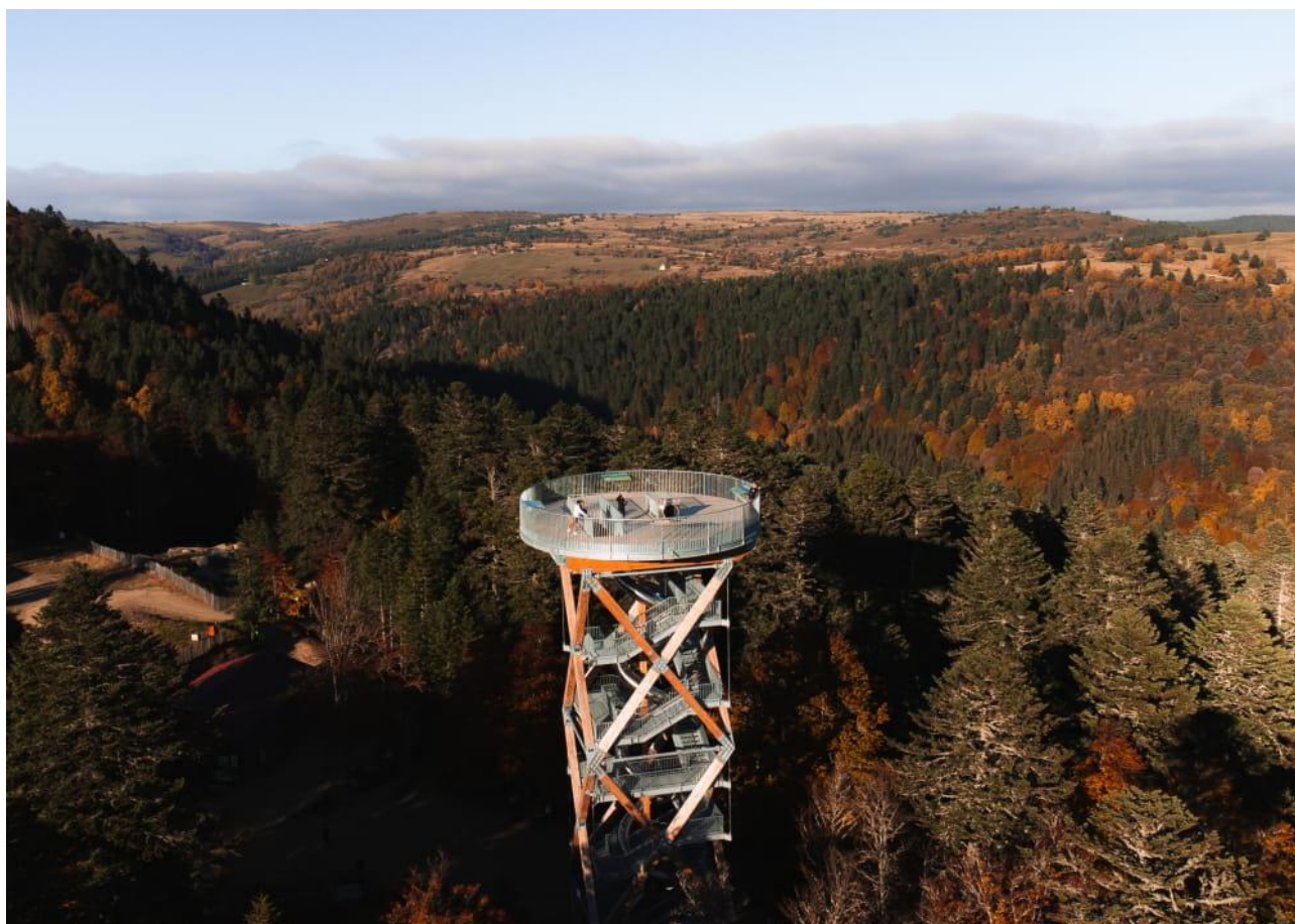
Figure 2 Photo de la tour d'observation de Prabouré - Commune de St Anthème
