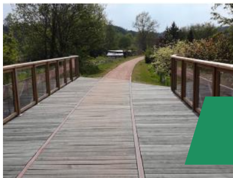
Aménagement réversible sur voie ferrée - CC Caux-Austre-Berthe
