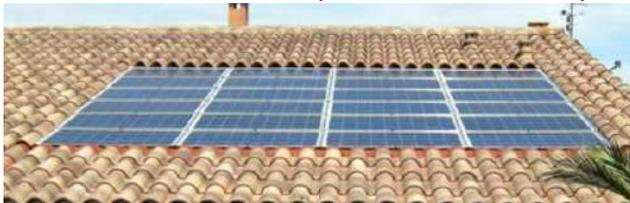
Panneaux encastrés parallèle à la pente de toit
