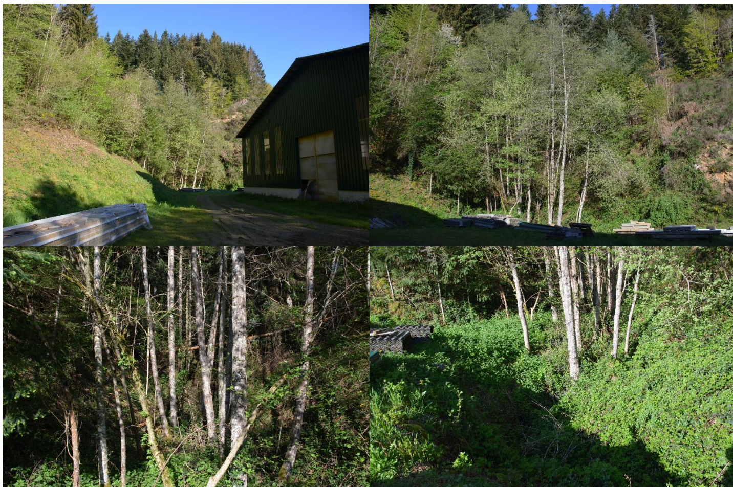
Le cours d'eau avant son busage à l'angle sud-ouest du grand bâtiment industriel (parcelles AI264 et AI265) (photos Luc Laurent)
