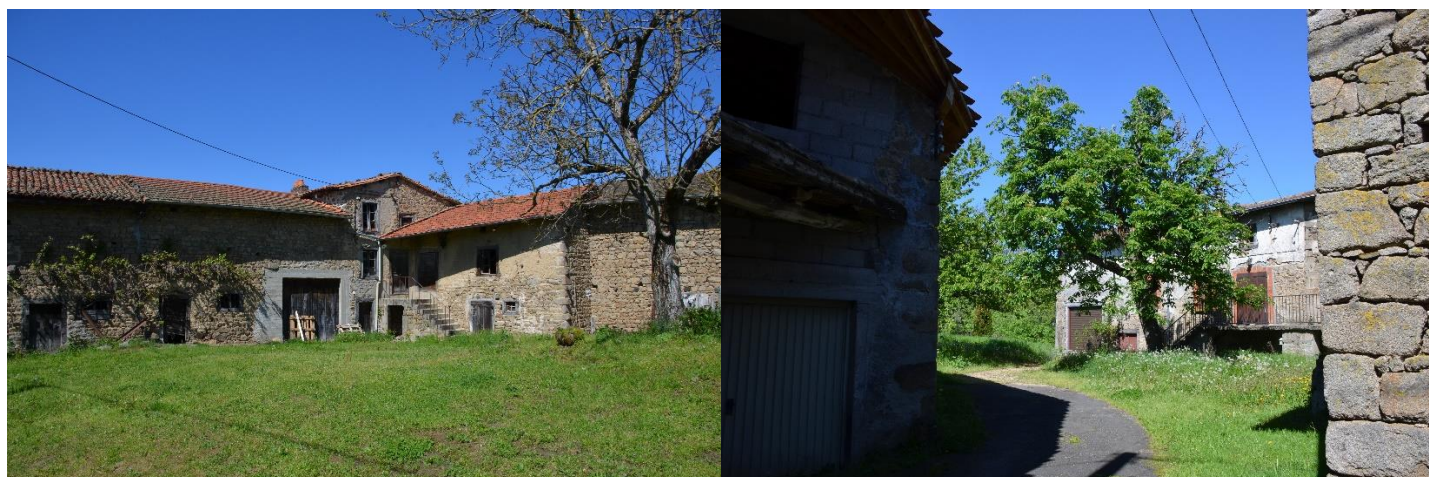
Le Garret : couderc (photo de gauche) et ouverture côté nord (parcelle ZB 471)
