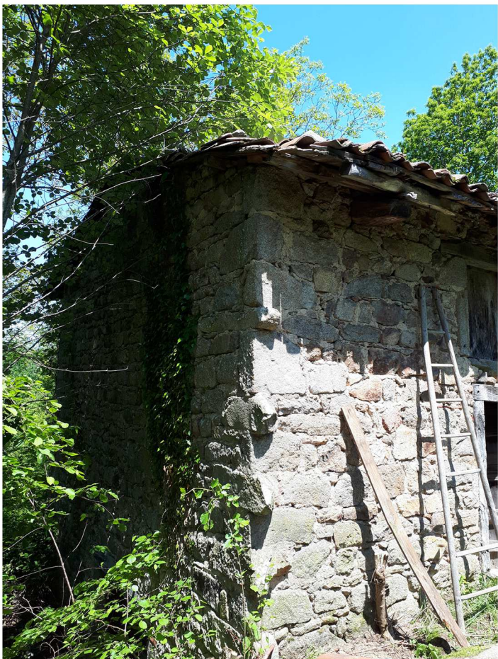
façade Sud-Est / photo du 11.06.2021
