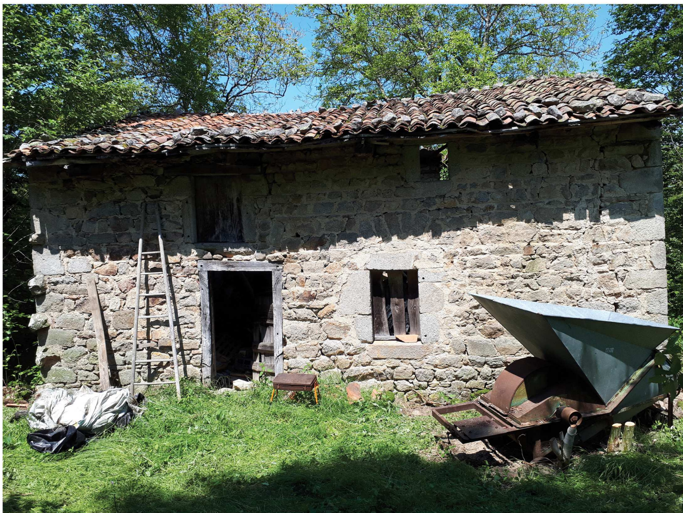
façade Sud-Est : image 20210811_125247_ du 11.06.2021
