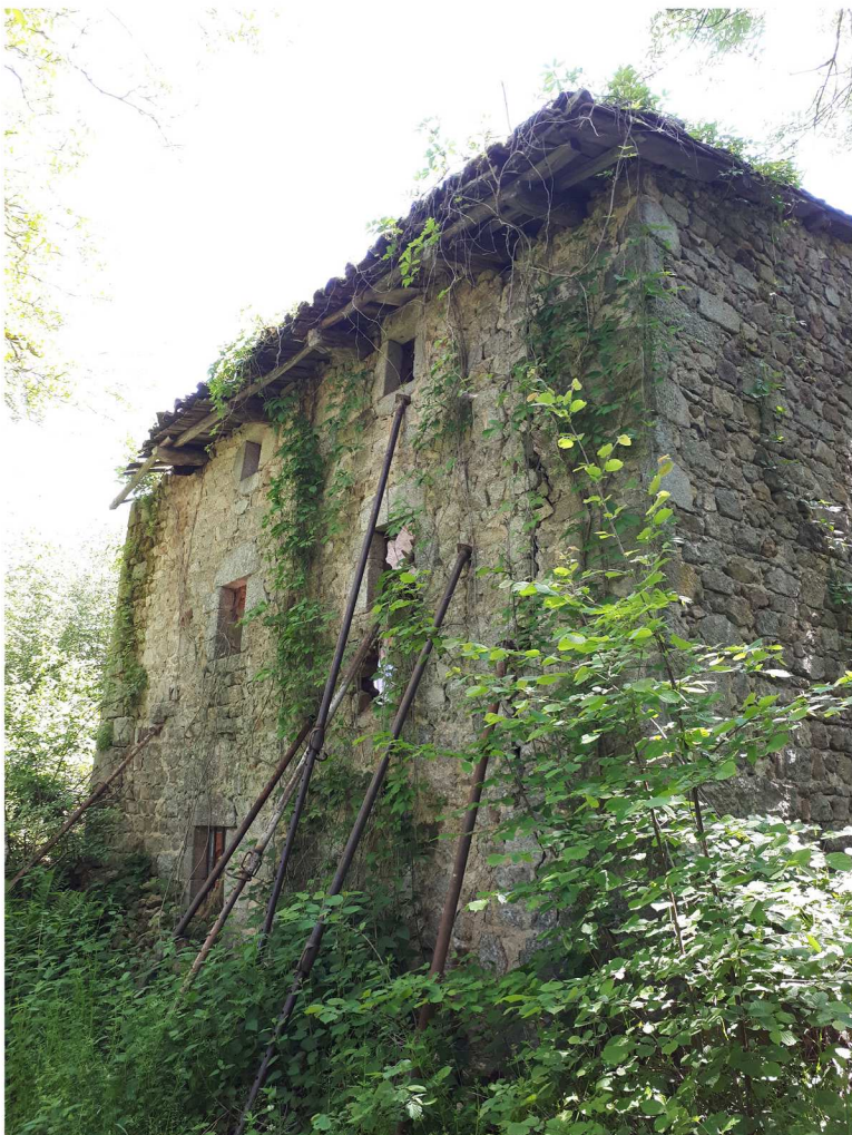
façades angle Ouest / photo du 11.06.2021
