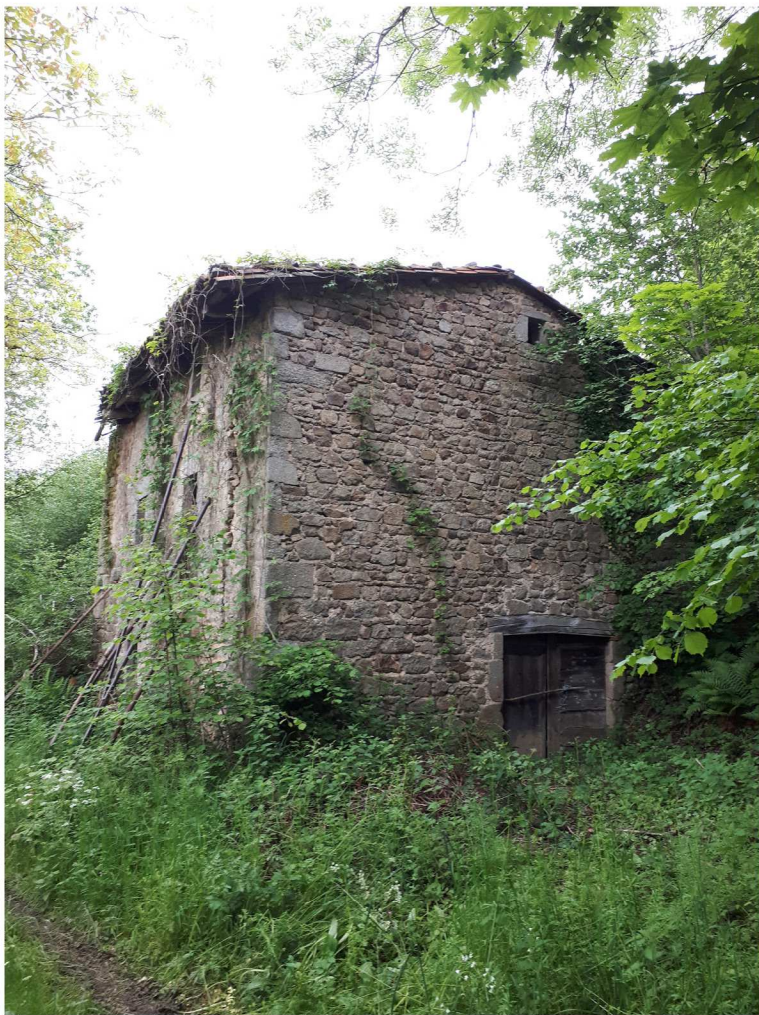
façades angle Ouest / photo du 11.06.2021
