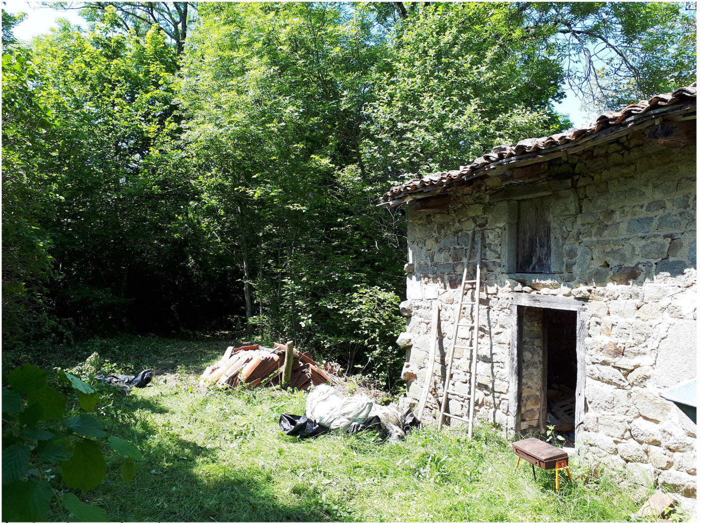
façade Sud-Est / photo du 11.06.2021
