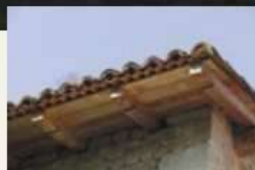
Débord de toit posé sur les chevrons. La volige brute doit rester apparente.
