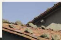
Les pierres posées sur les limites sensibles au vent – bords et faitage – évitent un scellement systématique.
