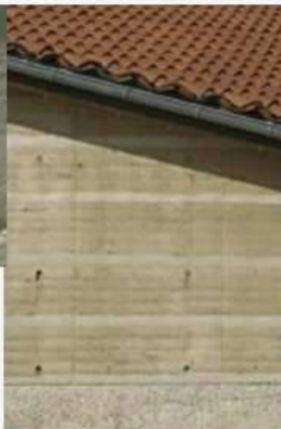
Le mur en pisé de cette grange en ruine a intégralement été reconstruit avec la terre récupérée sur le site.
