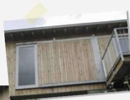
Les volets coulissants sur un rail associent bois et fer pour une mise en œuvre simple et économe inspirée des ateliers de coutellerie de la région.
