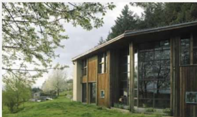
La façade sud de la maison est réalisée en bois et verre, enchassée entre deux murs pignons en maçonnerie traditionnelle.
