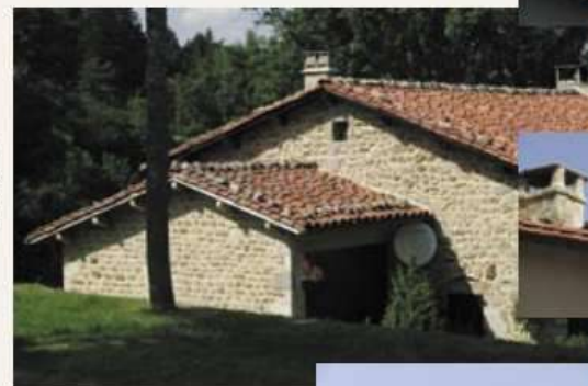
Les pierres posées sur les limites sensibles au vent – bords et faitage – évitent un scellement systématique.
